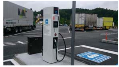
【道の駅「針テラス」の急速充電設備】
